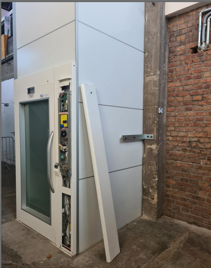
Spindelaufzug. Antrieb auf der Plattform.
